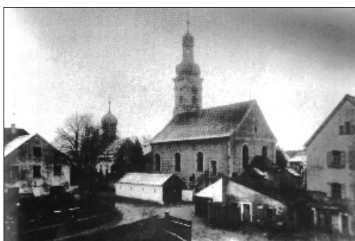
Auf dieser alten Aufnahme vom Holzertshof aus, sieht man noch das alte Feuerwehrhaus.
