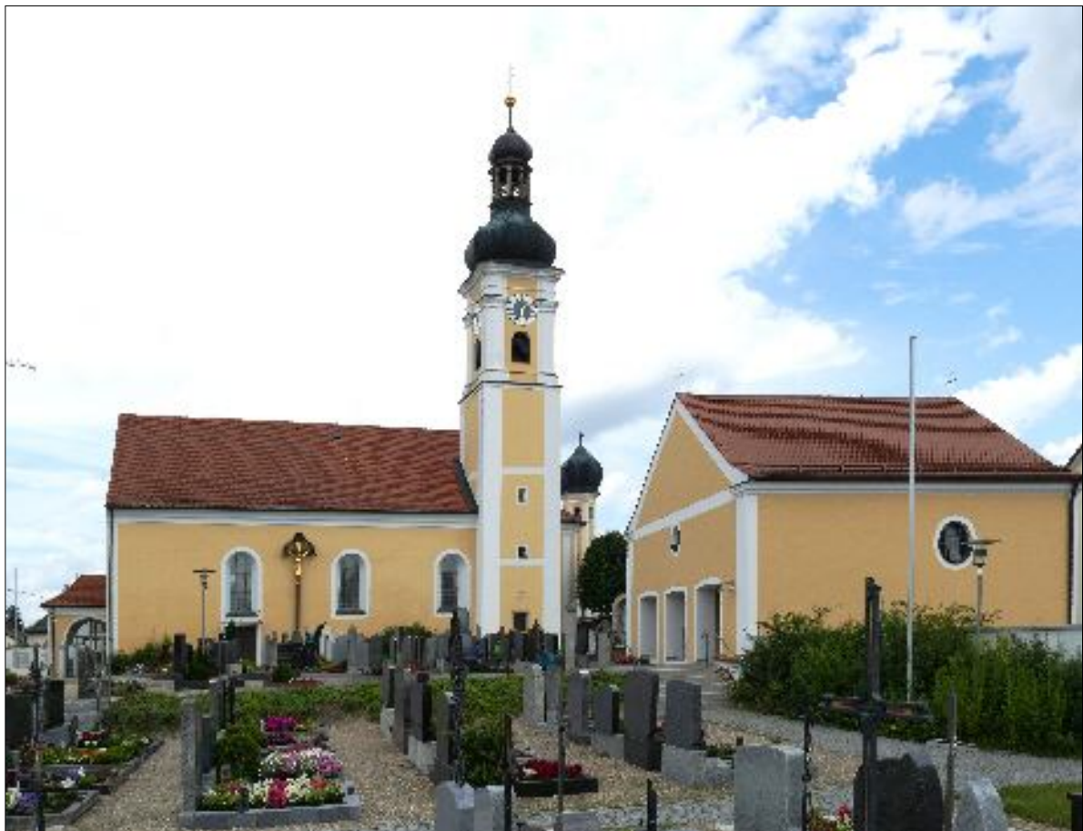
Gesamtansicht Kirche und Leichenhaus 2017
